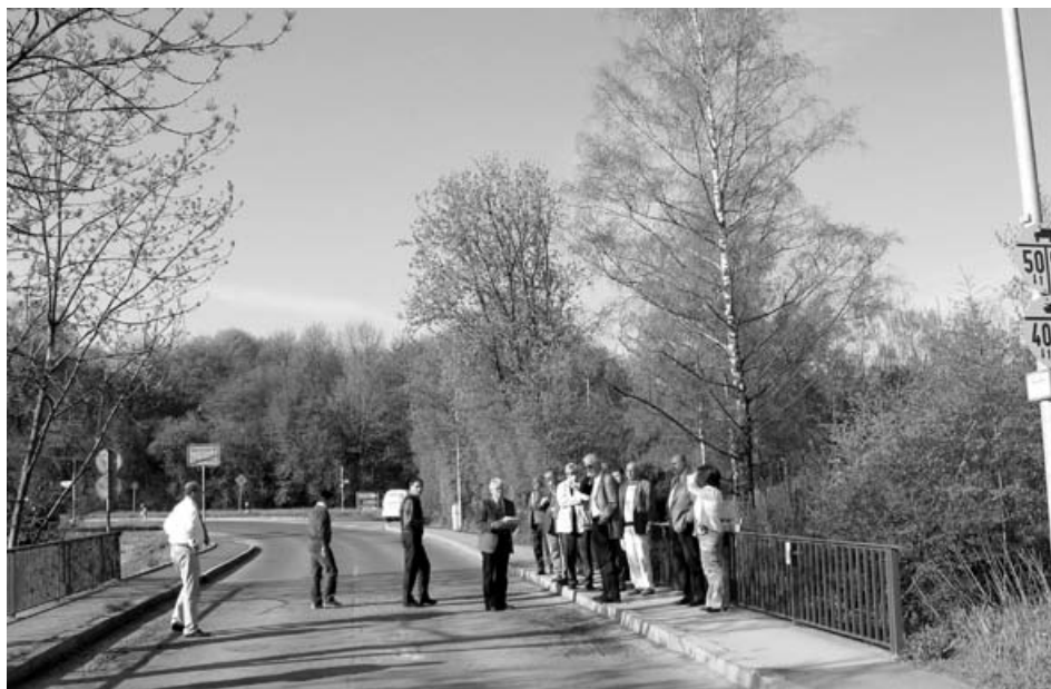
Besichtigung der Heimbachbrücke in Faurndau
