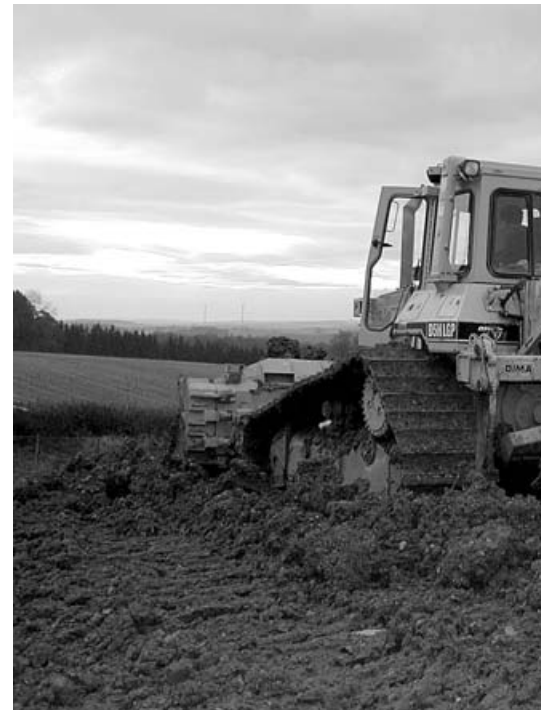
Moorraupe im Einsatz
