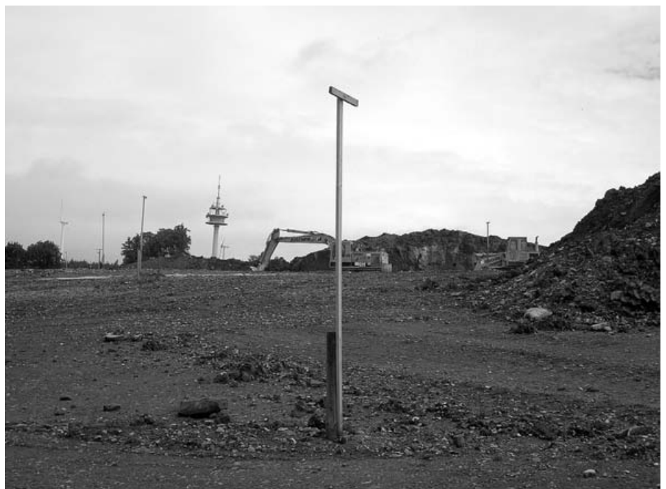
Lattenprofile markieren die Endhöhe der Profilierungsschicht.
