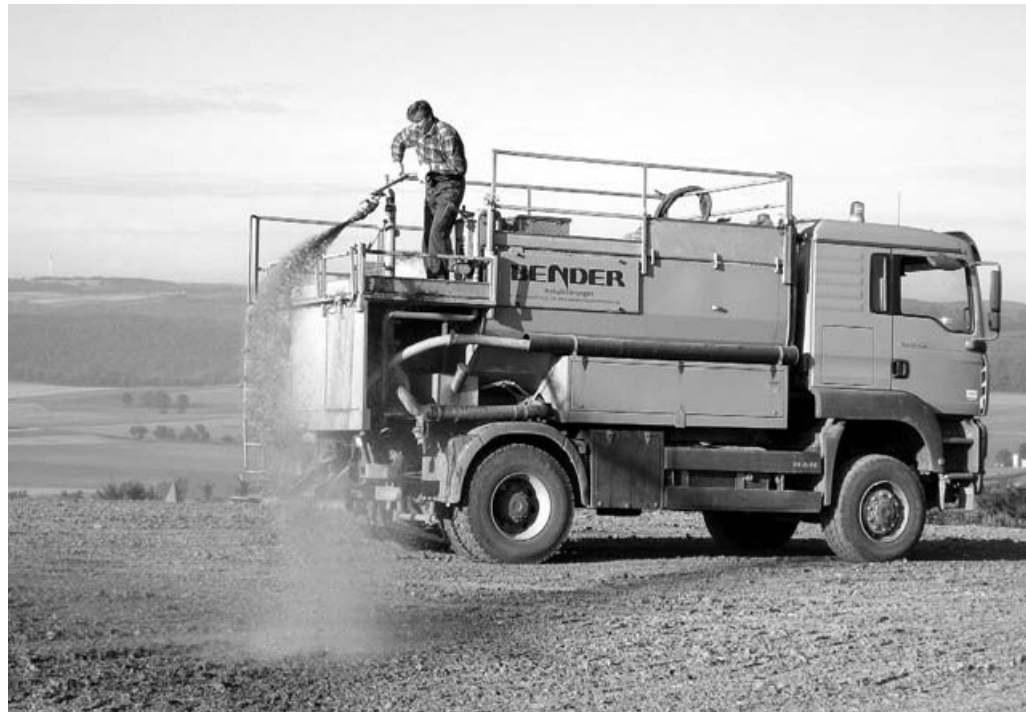
Spritzbegrünung der Böschungsbereiche
