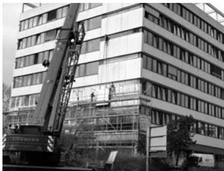
Landratsamt Fassadensanierung – Demontage der Beton-Fertigteileplatten
