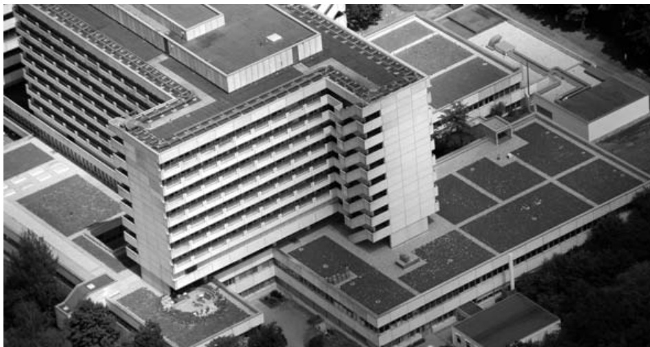
Klinik am Eichert – Luftaufnahme von Süd-Westen. Unten links im Bild: Dachterrasse vor der Entbindungsstation (rund). Sanierte Dachflächen über dem Erdgeschoss mit extensiver Dachbegrünung
