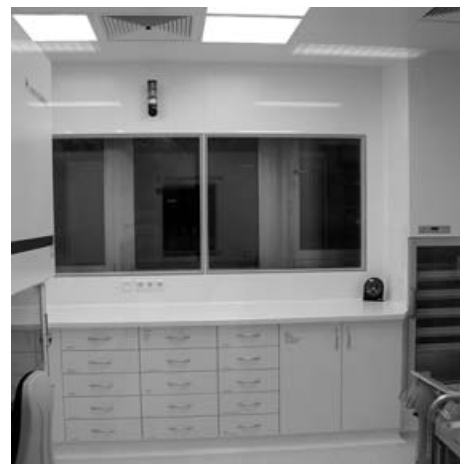
Klinik am Eichert – Reinraum in der Zentralapotheke mit Blick durch die vorgesetzte Wand auf die Fassade.
