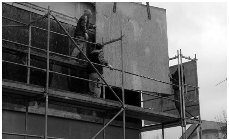
Landratsamt Fassadensanierung – Demontage der Beton-Fertigteileplatten
