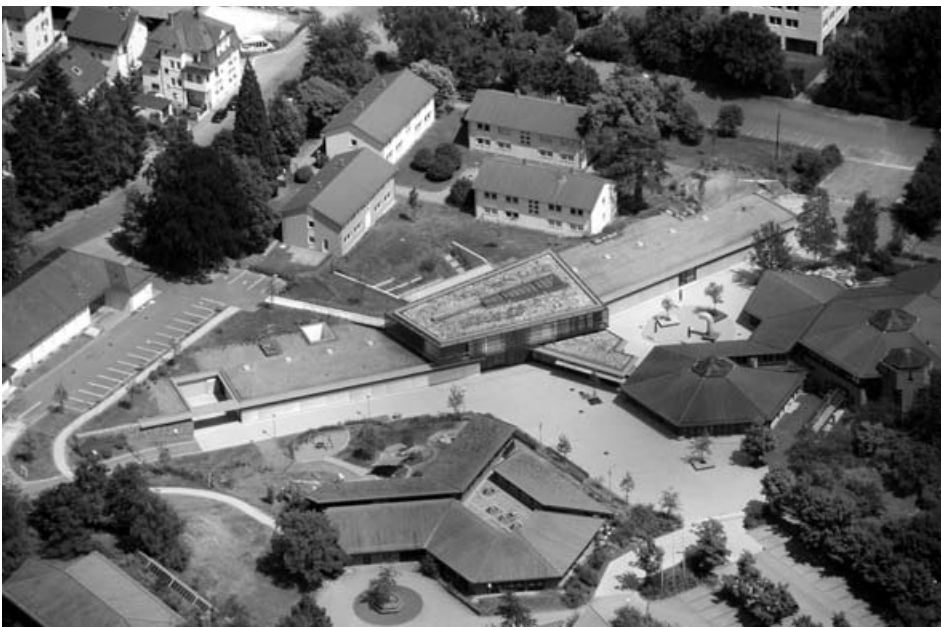
Luftaufnahme von Südwesten, im Vordergrund der Schulerburg-Kindergarten. In der Bildmitte der langgestreckte Erweiterungsbau, vorne rechts der „Altbau“ der Bodelschwingh-Schule. Oben die ehemaligen Übergangswohnheime, jetzt Außenstellen des Landratsamtes.
