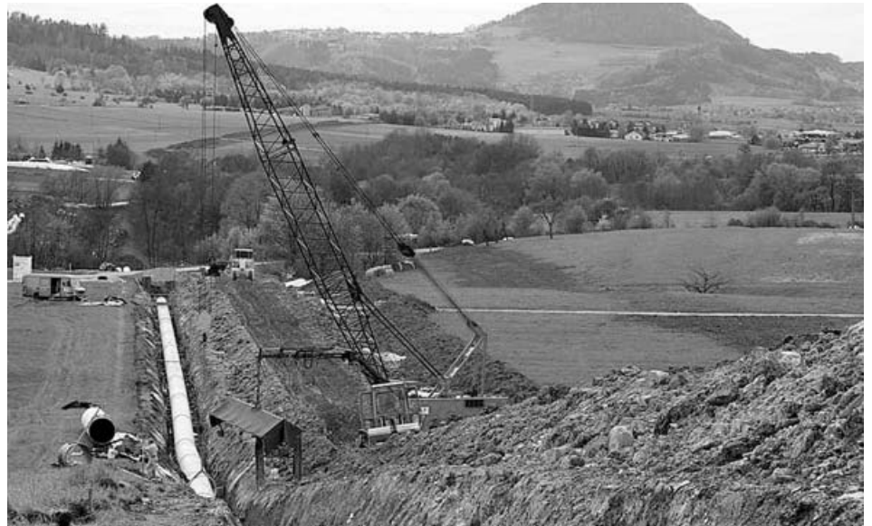
Rohreinbau durch Fachfirma
