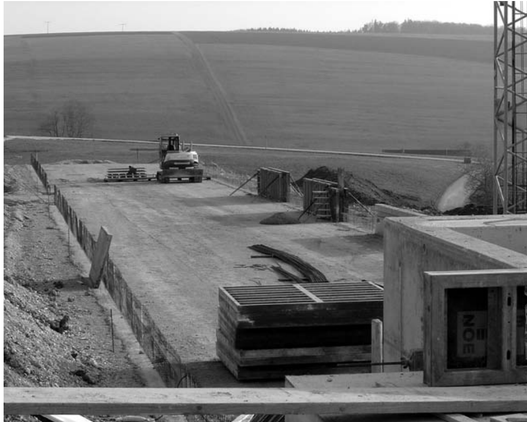
Errichtung des Fundaments für die Klärschlamm-trocknungsanlage
