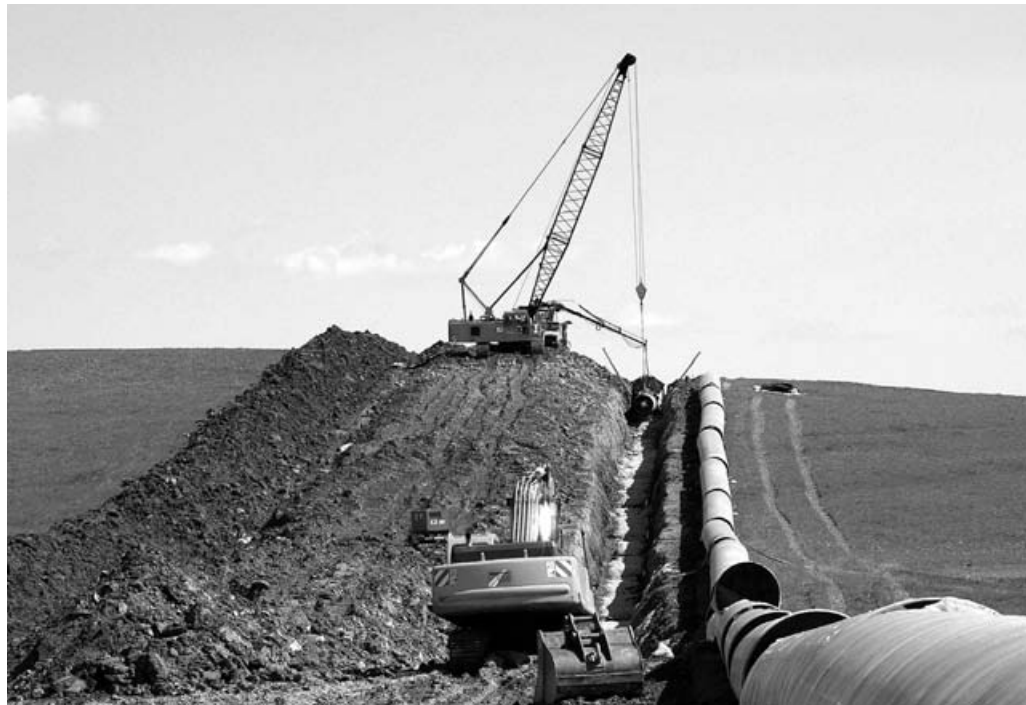
Rohrverlegung nach ausgehobener Trasse
