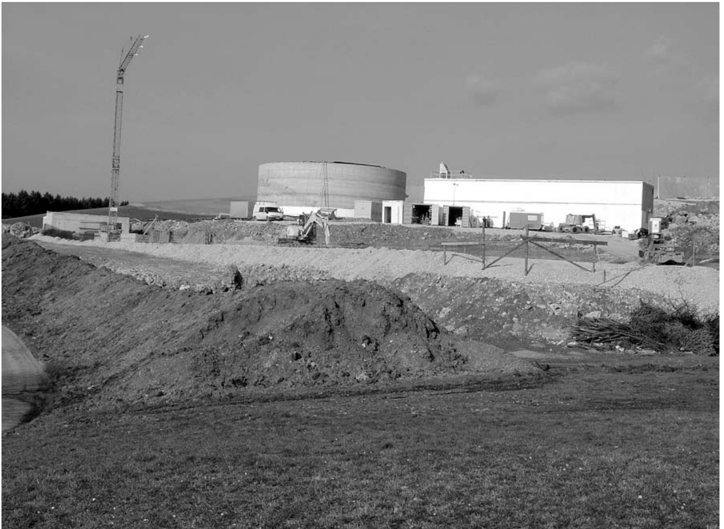
Baustelle mit den Fermentern im Hintergrund
