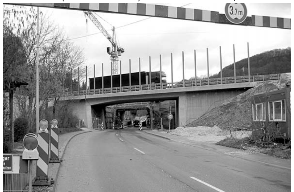
Baubeginn am Abschnitt Gruibingen-Mühlhausen der A8 – Hier: Neubau der Brücke über die L1217
