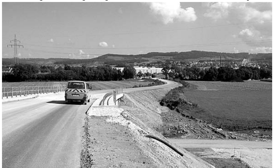
Die K 1404 verbindet neue und alte B10 zwischen Eislingen und Salach.
