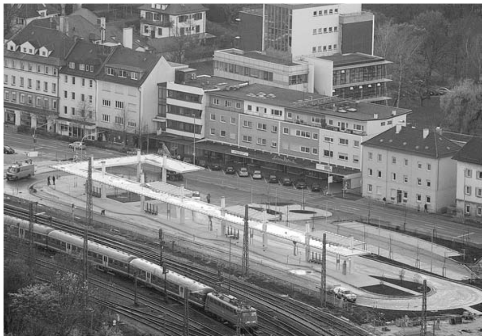
Der neue ZOB in Geislingen kurz vor der Fertigstellung
